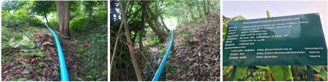
๒๖.โครงการปรับปรุงเปลี่ยนท่อระบบประปาภูเขา บ้านป่าเต้า หมู่ ๑๑ ท่อPVC ๔ นิ้ว ชั้น ๘.๕ ปลายบาน ยาวรวม ๗๖๐ เมตร
