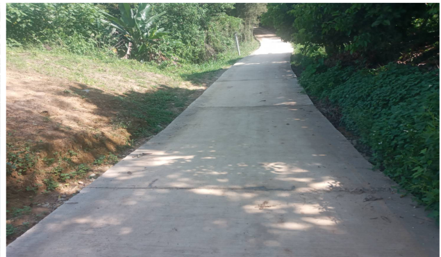
๒๐.โครงการก่อสร้างถนนคอนกรีตเสริมเหล็ก บ้านสันกลาง หมู่ ๕ (สายนาทุ่งสอง) (สายนาทุ่งสอง) ขนาดกว้าง ๓ เมตร ยาว ๑๐๔ เมตร หนา ๐.๑๕ เมตร
