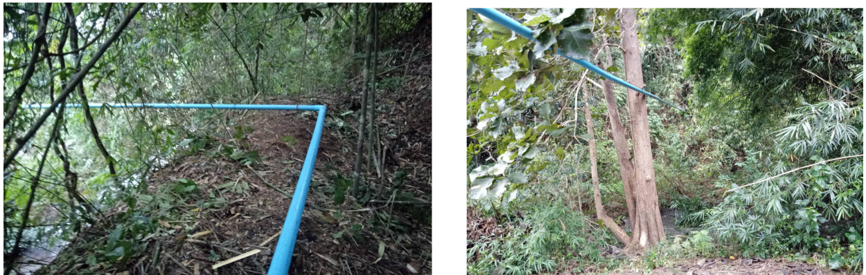
๒๗.โครงการปรับปรุงระบบท่อประปาภูเขา บ้านน้ำสวดหมู่ ๑๒ จากสวนนางจิตร เขียวชาญ -หมู่บ้านท่อ PVC ๓ นิ้ว ชั้น ๘.๕ ปลายบาน ยาวรวม ๑,๑๒๐ เมตร
