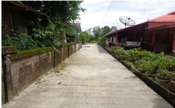
๒๒.โครงการปรับปรุงถนนคอนกรีตเสริมเหล็ก บ้านน้ำเพาะ หมู่ ๑๐ (หน้าบ้านนายอินทอง กองแสง) ขนาดกว้าง ๔ เมตร ยาว ๑๐๒ เมตร หนา ๐.๑๐ เมตร
