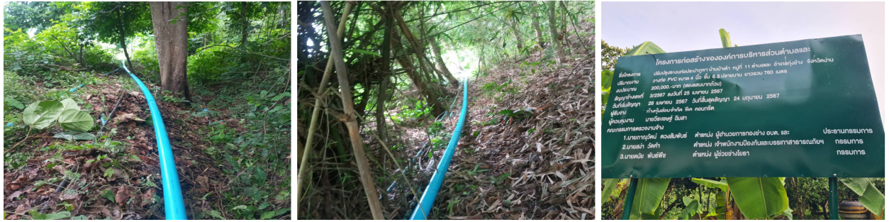
๒๖.โครงการปรับปรุงเปลี่ยนท่อระบบประปาภูเขา บ้านป่าเต้า หมู่ ๑๑ ท่อPVC ๔ นิ้ว ชั้น ๘.๕ ปลายบาน ยาวรวม ๗๖๐ เมตร
