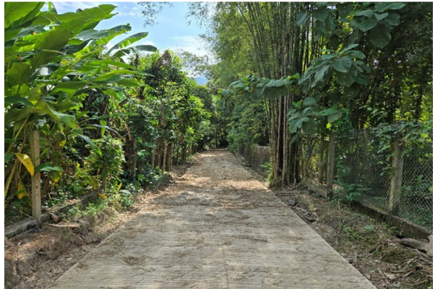
๒๐.โครงการก่อสร้างถนนคอนกรีตเสริมเหล็ก บ้านสันกลาง หมู่ ๕ (สายนาทุ่งสอง) (สายนาทุ่งสอง) ขนาดกว้าง ๓ เมตร ยาว ๑๐๔ เมตร หนา ๐.๑๕ เมตร
