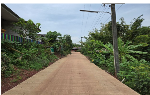
๒๒.โครงการปรับปรุงถนนคอนกรีตเสริมเหล็ก บ้านน้ำเพาะ หมู่ ๑๐ (หน้าบ้านนายอินทอง กองแสง) ขนาดกว้าง ๔ เมตร ยาว ๑๐๒ เมตร หนา ๐.๑๐ เมตร
