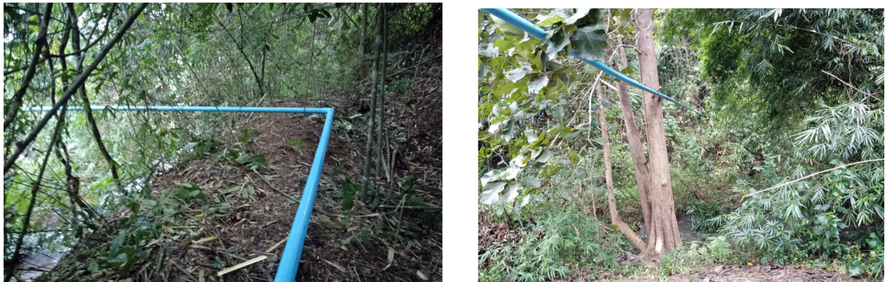
๒๗.โครงการปรับปรุงระบบท่อประปาภูเขา บ้านน้ำสวดหมู่ ๑๒ จากสวนนางจิตร เขียวชาญ -หมู่บ้านท่อ PVC ๓ นิ้ว ชั้น ๘.๕ ปลายบาน ยาวรวม ๑,๑๒๐ เมตร
