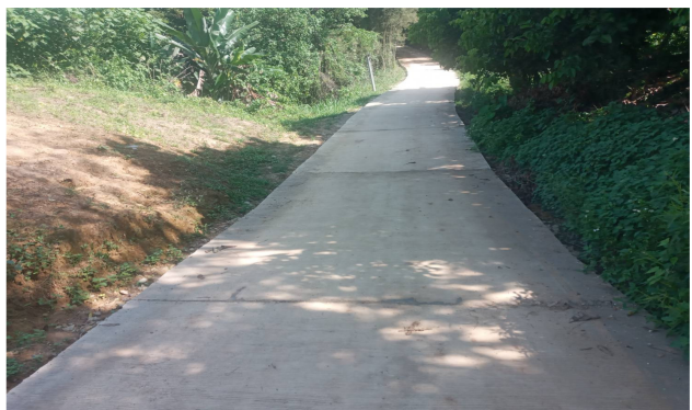
๒๐.โครงการก่อสร้างถนนคอนกรีตเสริมเหล็ก บ้านสันกลาง หมู่ ๕ (สายนาทุ่งสอง) (สายนาทุ่งสอง) ขนาดกว้าง ๓ เมตร ยาว ๑๐๔ เมตร หนา ๐.๑๕ เมตร
